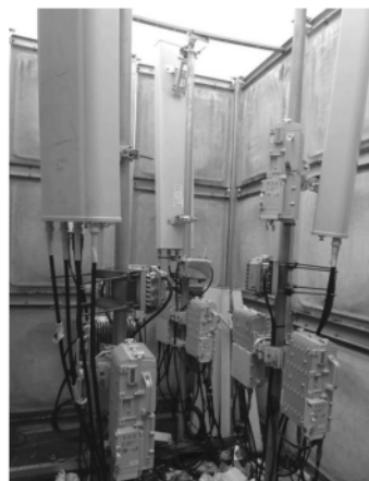
(b) 劈裂天线安装实图
